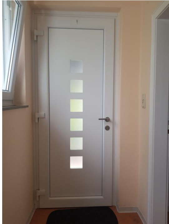
Eingangsbereich (von innen)
