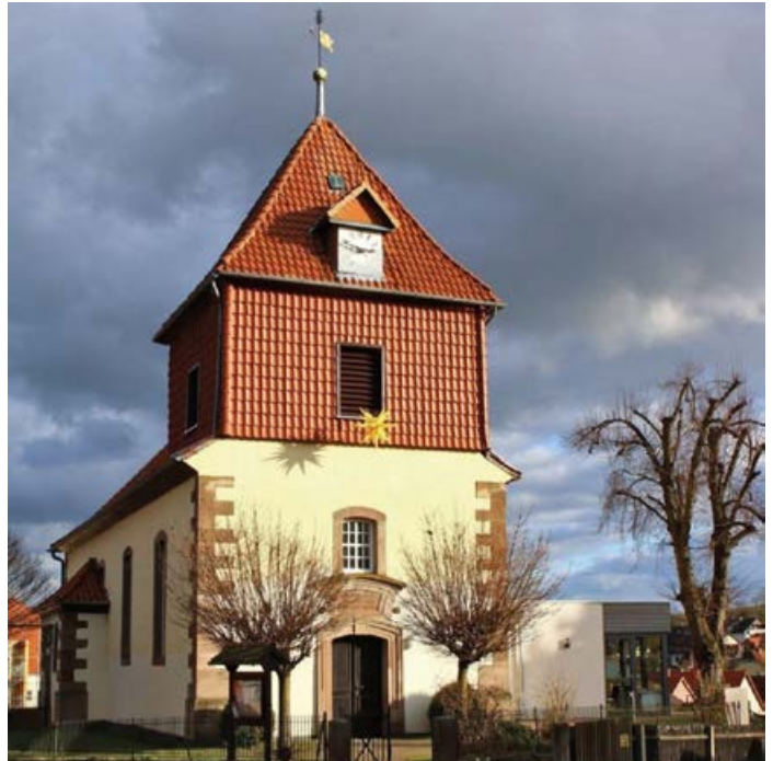
St. Cosmas und Damian-Kirche, Ebergötzen, recht angebaut das neue Gemeindehaus
